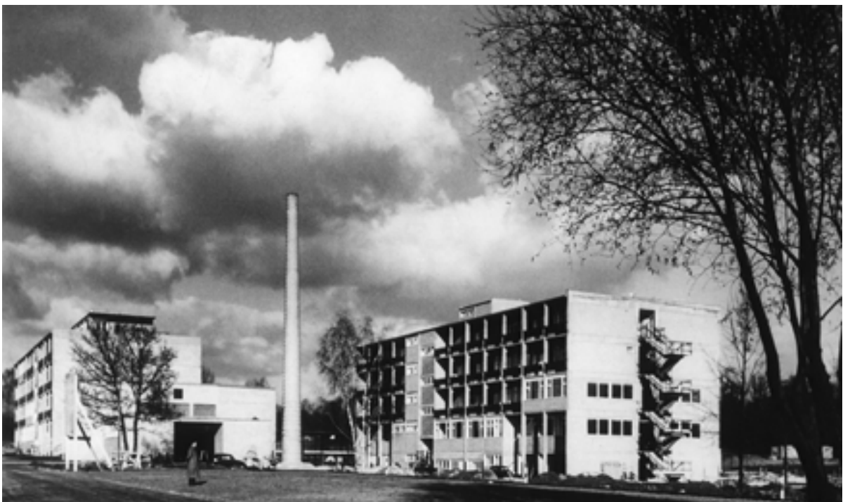
4 Das Institut für Mikrobiologie bezog 1955 den dritten Stock des Zoologischen Instituts in der Siesmayerstraße 70. Als die Mitarbeiter im Laufe der Jahre immer zahlreicher wurden, mussten die Balkone teilweise ausgebaut werden, um mehr Laborfläche zu gewinnen.
